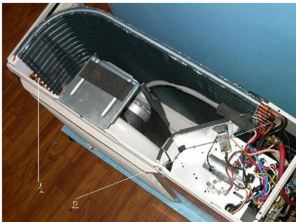
**Определение точки установки термодатчика.** На рис. 3. показан вид стандартного конденсатора внешнего блока.
